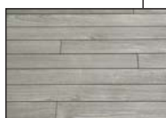
Bois après 6 mois sans traitement
