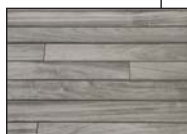
Bois après 6 mois sans traitement
