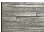
Bois après 6 mois sans traitement
